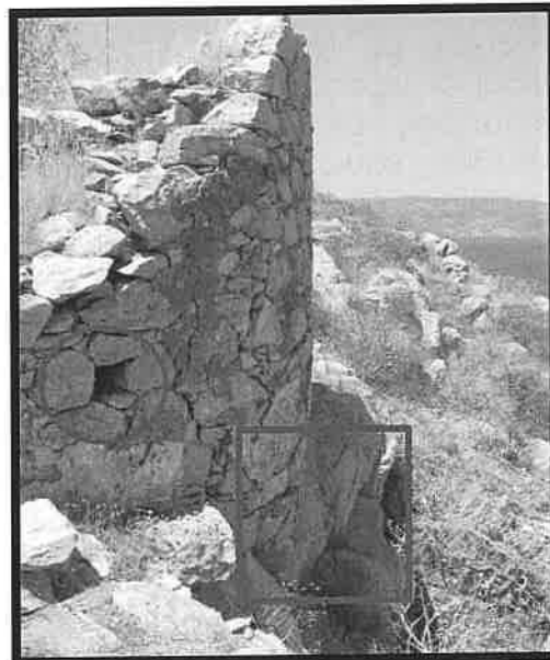
Εικ.38. Νοτιανατολική άποψη του ανεμόμυλου έδραση του ανεμόμυλου σε βράχο.
